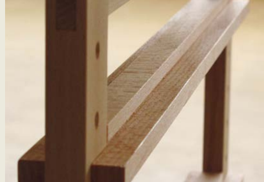
Detail: Ladenlaufleiste mit Dübel auf Rahmen
