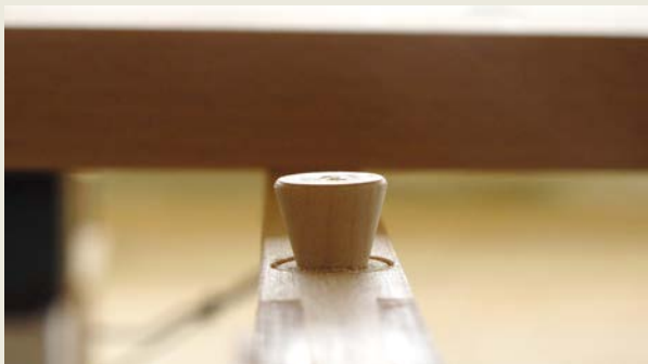
Detail: runder Schwalbenschwanzzinke
