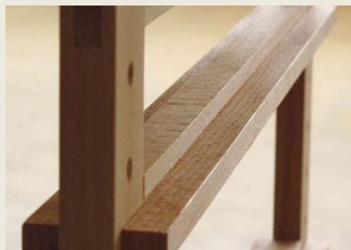
Detail: Ladenlaufleiste mit Dübel auf Rahmen
